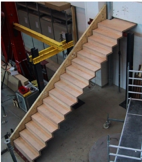
Bild 3 Eingebaute Falwerkterppe
