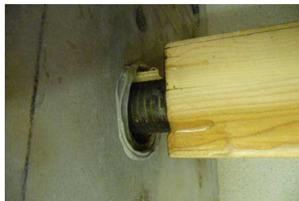
Anschluss an eine Betonwand
